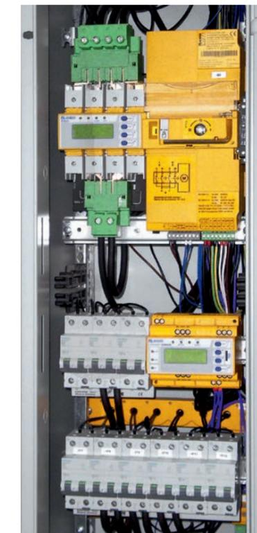
Ein Versuchsaufbau hat bestätigt, dass die passive Belüftung des Verteilerschranks bei einer Umgebungstemperatur von 22°C, bestückt mit einem 8 kVA-IT-Transformator, die Innentemperatur an den relevanten Stellen innerhalb des Gehäuses, auch nach 24 h unter Nennlast, nicht über 40°C ansteigen lässt.
